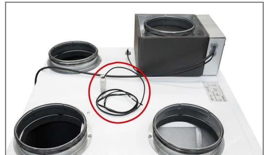
6. Der T1-Sensor wird vom 8-poligen in den Außenluftkanal gezogen (30 cm vor der Vorheizregister).
