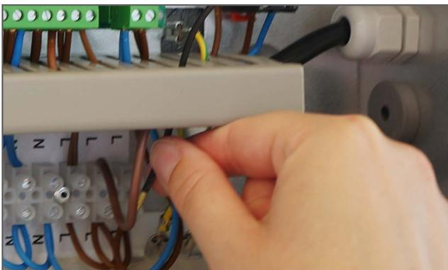
5. Leitungen wie im Schaltplan angezeigt anschließen.
