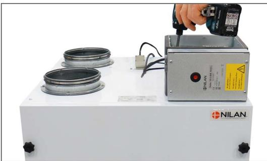
3. Die Vorheizfläche wird am Außenluftkanalanschluss an der Oberseite (Standard) oder an der Seite des Geräts installiert (in diesem Fall muss die Abdeckplatte bewegt werden, um das Loch in der Oberseite abzudecken). Stellen Sie sicher, dass die Heizfläche so platziert wird, dass die Abdeckung für die Steuerung leicht geöffnet werden kann.
