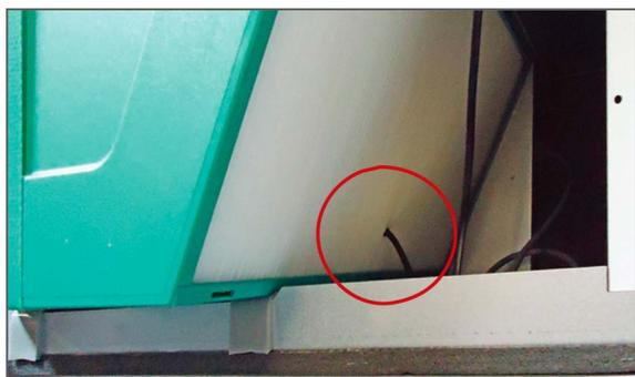
3. Den T4-Fühler am Kreuzstromwärmetauscher abnehmen.
