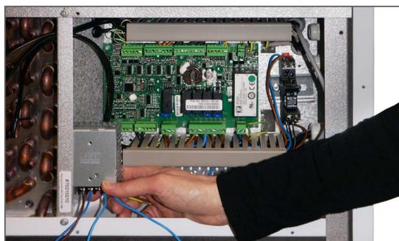
6. Das Kabel vom CO<sub>2</sub> der Sensor durch die Kabeldurchführung zur Automatik führen. Den Stromversorgungsbox wird bei der Steuerung montiert (2 Löcher soll gebohrt werden).
