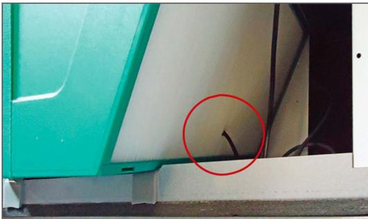
3. Den T4-Fühler aus dem Gegenstromwärmetauscher herausziehen.
