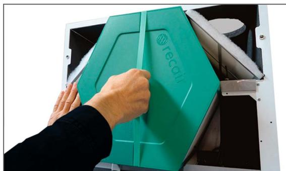
4. Den Wärmetauscher abnehmen, indem an der Schnur gezogen wird (darf nicht durchgeschnitten werden).
