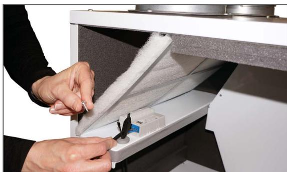
5. Montiere das CO<sub>2</sub> Fühler mit selbstbohrende Schrauben (liegt im CO<sub>2</sub> -Sensor-Kit liegt bei) im Regal aus Metall unter die Abluftfilter .
